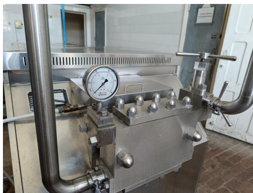
Р и с. 2. Гомогенизатор. Рабочая зона, манометр контроля давления
